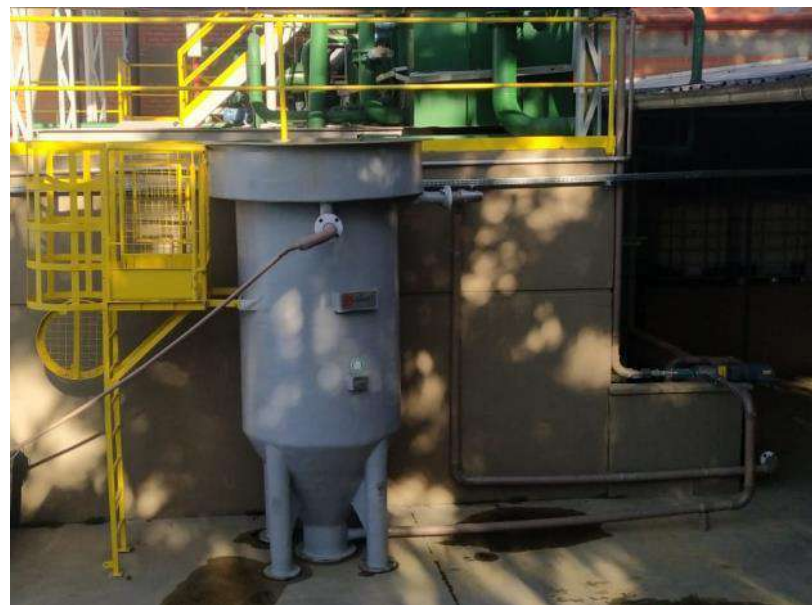
Adensador Instalado
