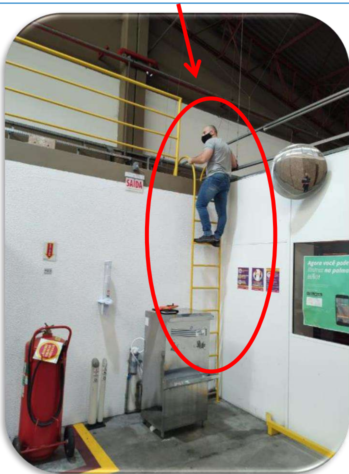
Antes – Escada Inadequada
