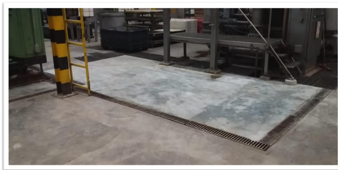
Manutenção do piso
